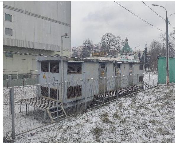
Фото 104. Трансформаторная подстанция
