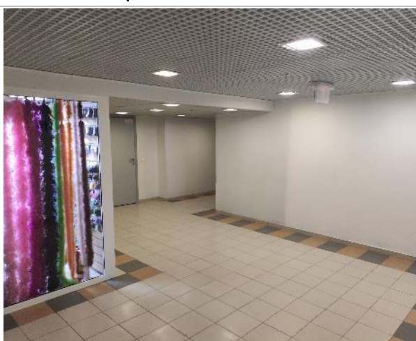
Фото 75. Помещения -1-го этажа
