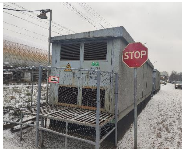
Фото 106. Трансформаторная подстанция
