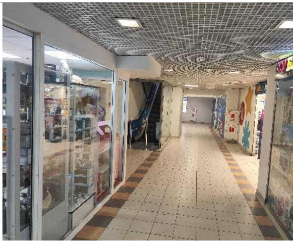
Фото 88. Помещения -1-го этажа
