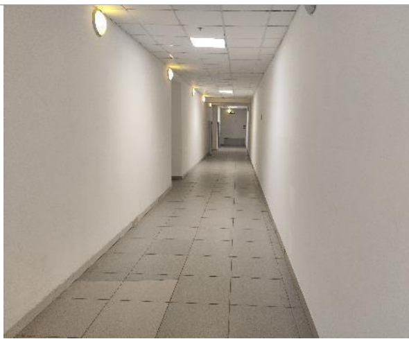
Фото 40. Помещения 2-го этажа
