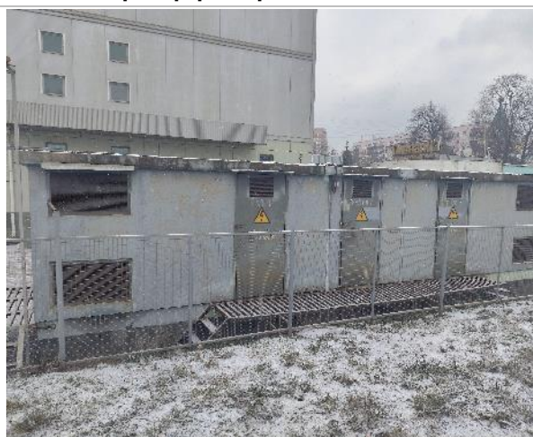
Фото 105. Трансформаторная подстанция
